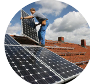
Daken met zonnepanelen
