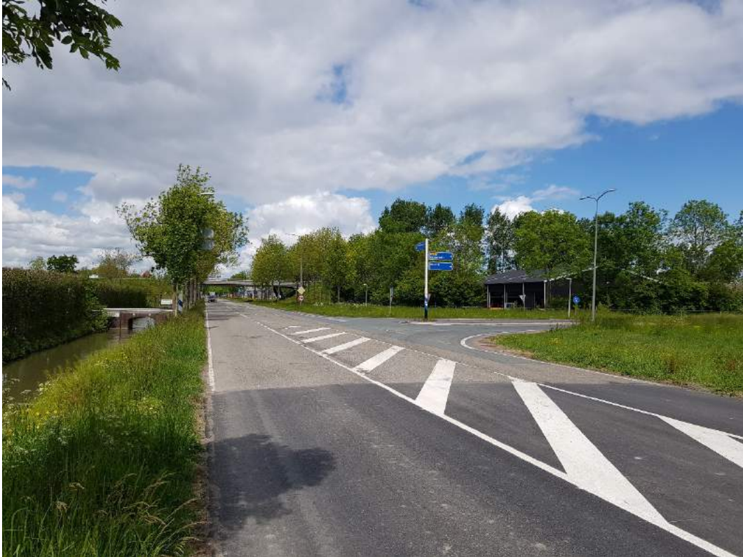
Middenweg, zicht op viaduct en afslag N244
