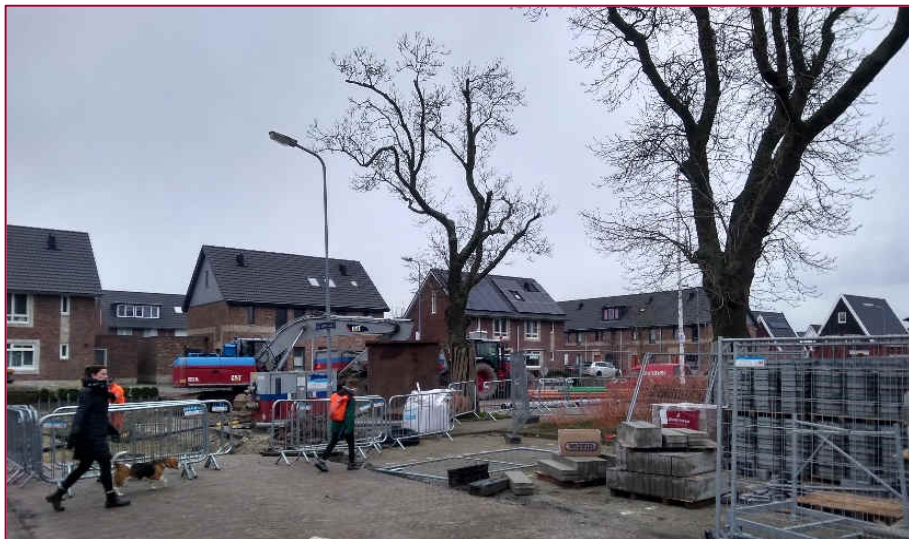
Figuur 2.1: werkzaamheden op het kruispunt
