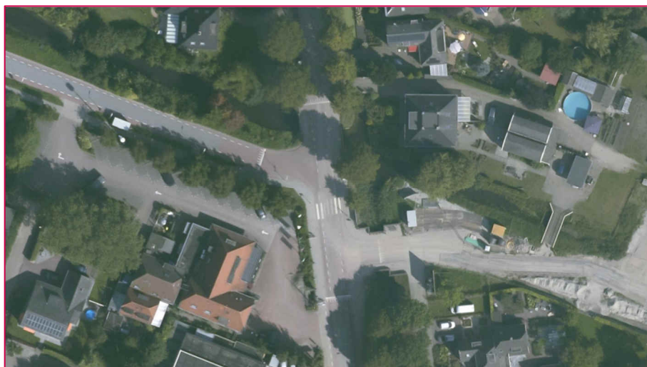
Figuur 5.1: het kruispunt vanuit de lucht (foto: Cyclomedia)
