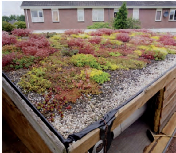
Afbeelding 14.2: Sedum dak op schuurtje, bron: GAW | RIONED.
