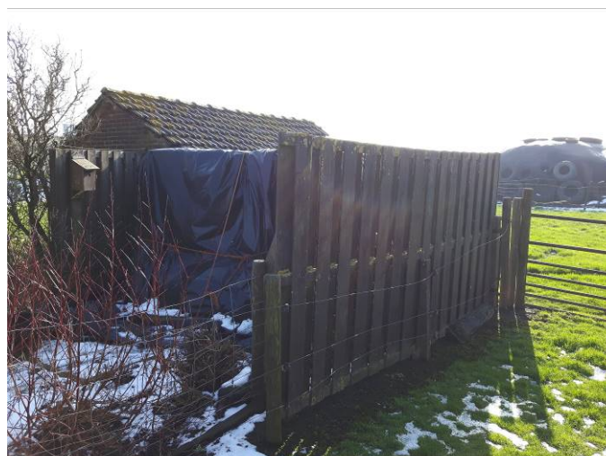
Foto 5: Omgeving voormalige brongasinstallatie
