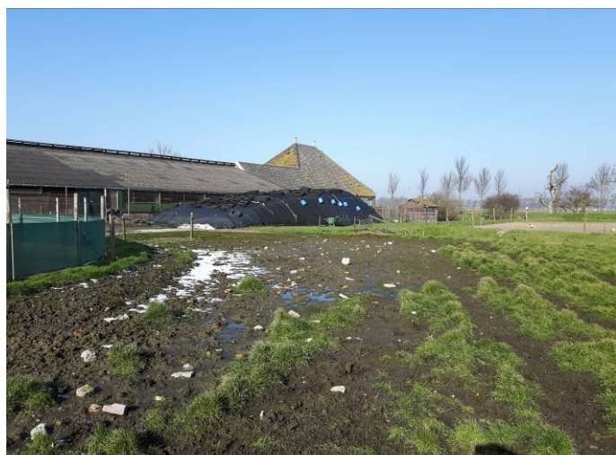
Foto 10: Puin op maaiveld bij uitloop dam 1
