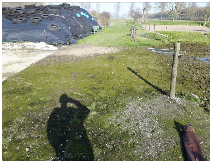
Foto 8: Opgebrachte slakkenlaag dam 1
