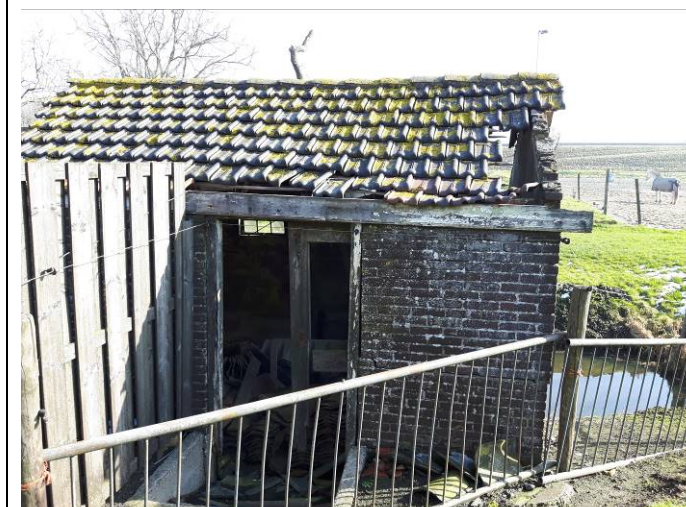
Foto 6: Opstal voormalige brongasinstallatie
