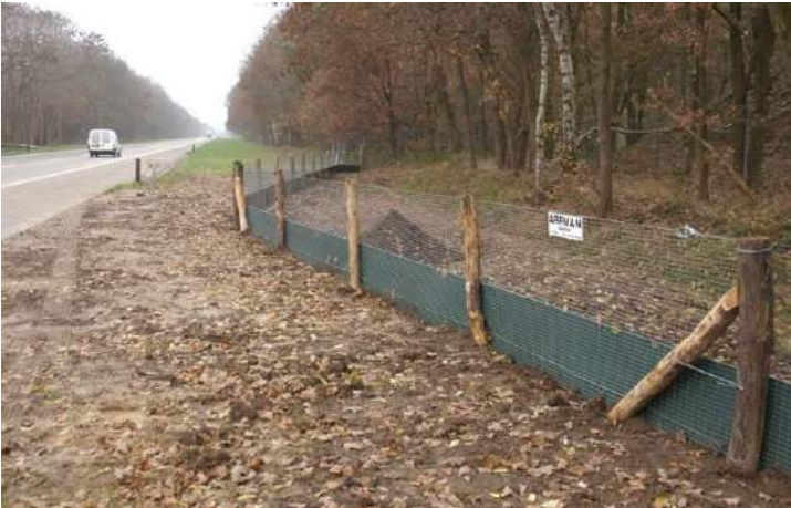
Figuur 11. Voorbeeld wildraster gecombineerd met amfibieënscherm.
