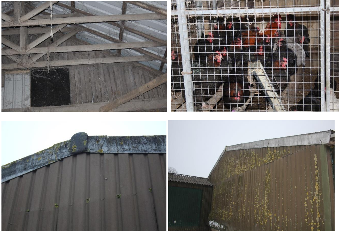
Figuur 4. Detailfoto's Foto 1 en 2 zijn van de te slopen schuur waar nu kippen in zitten. Foto 3 en 4 zijn van de zijanten van de stal waar tegenaan wordt gebouwd.
