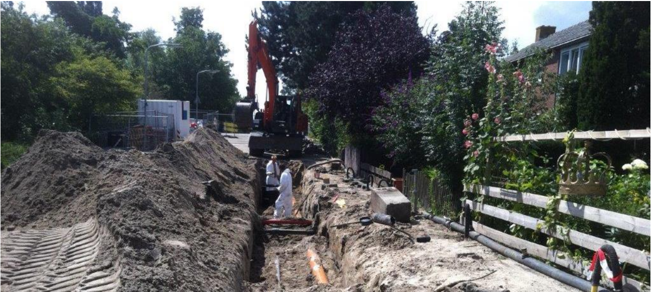
Figuur 8 - Aanleg van een gescheiden stelstel in Landsmeer (Bron: gemeente Landsmeer)
