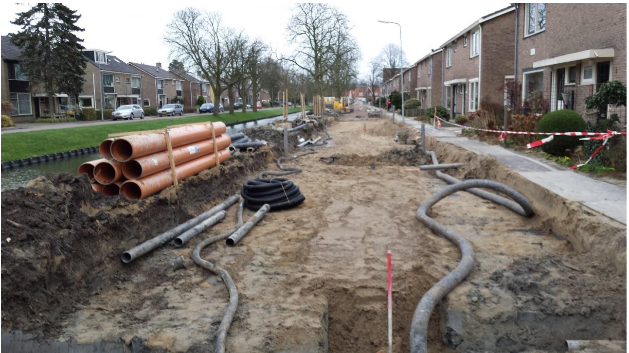
Rioolwerkzaamheden Wilhelminasingel Zuidoostbeemster
