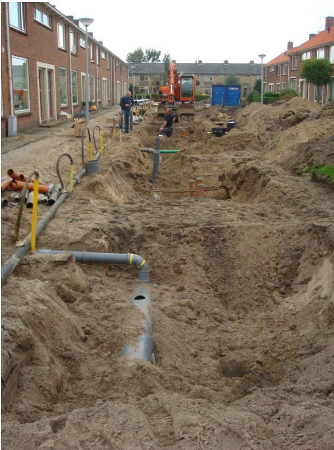
Figuur 9 – Rioleringswerken (Bron: gemeenten Oostzaan en Wormerland)
