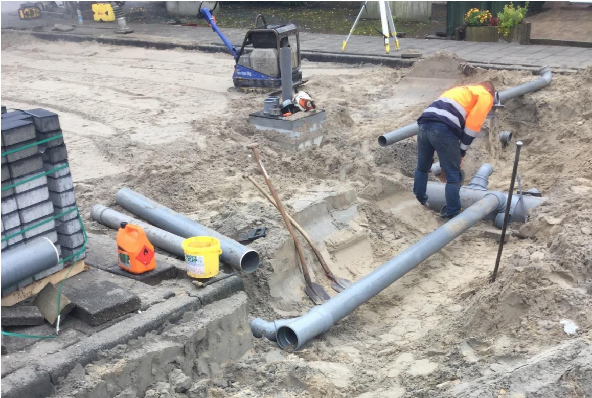
Figuur 14 – Afkoppelen van de hemelwaterafvoer in Monnickendam (Bron: gemeente Waterland)
