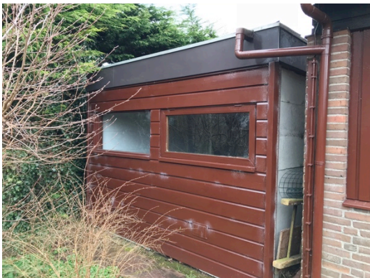
Achterkant v/d garage geschakeld aan woning
