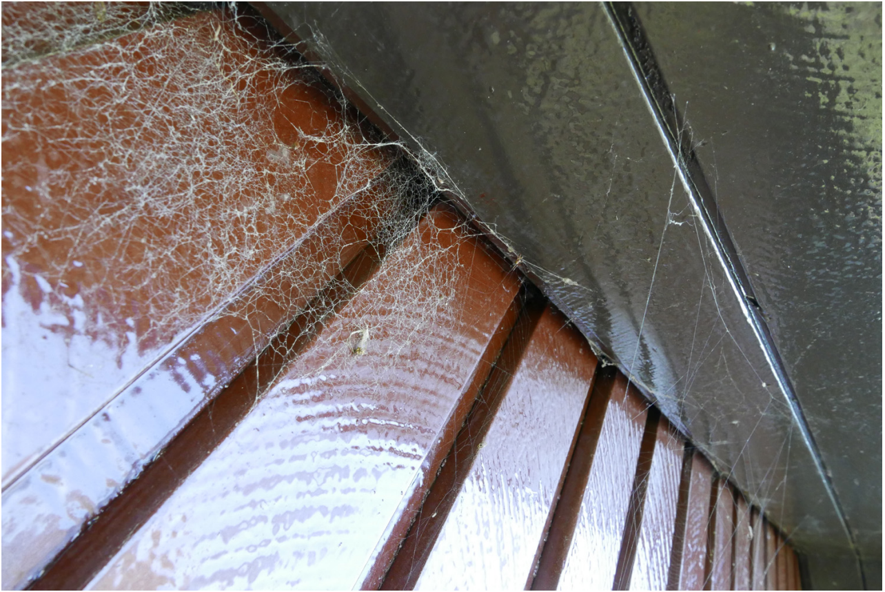
Afb.2: Kier boven de houten bekleding vol met spinnenrag.
