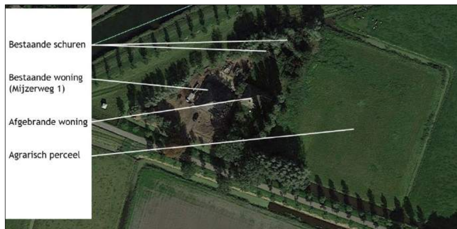
Figuur 3. Bestaande situatie in het plangebied
