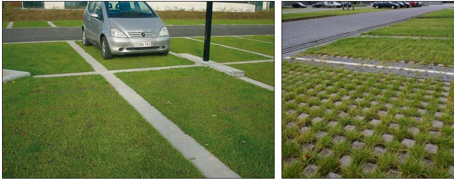
Referentiebeelden groene parkeervakken. Scheiding van vakken door stroken verharding tussen de vakken
