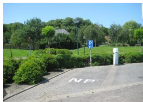
Figuur 2: Oplaadpunt elektrisch vervoer bij gemeentehuis.
