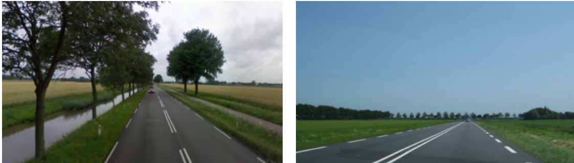
Figuur 5: Referentiebeelden Gebiedsontsluitingswegen buiten de bebouwde kom (links N243, rechts Bamestraweg).
