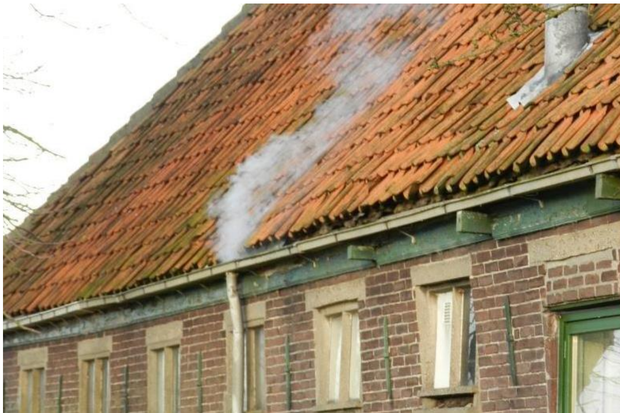
Rookproef foutaansluiting Landsmeer
