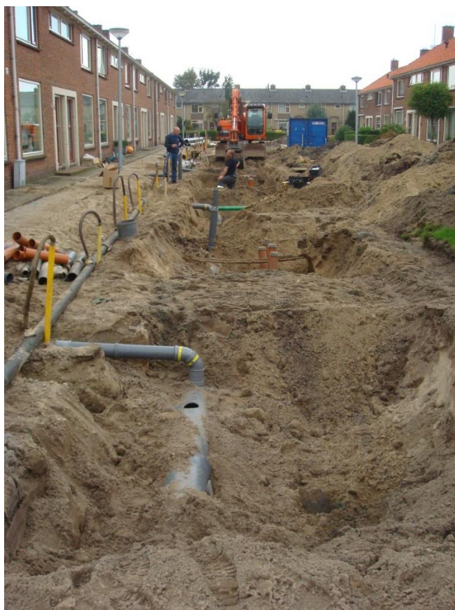
Figuur 9 – Rioleringswerken (Bron: gemeenten Oostzaan en Wormerland)
