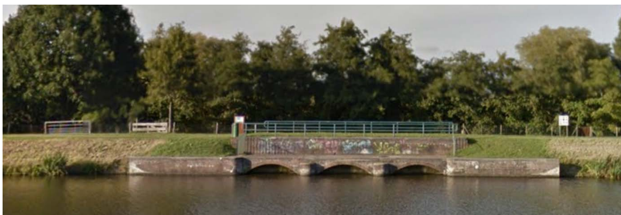
Inlaatsluis Zuidelijke Beemsterringdijk recent
