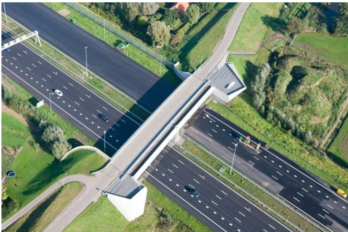
(Afbeelding van kruising A2 met de hoofdverdedigingslijn van de Nieuwe Hollandse Waterlinie. De bruggenhoofden zijn ontworpen met betonnen constructies uit de NHW in het achterhoofd. Foto beeldbank Rijkswaterstaat)
