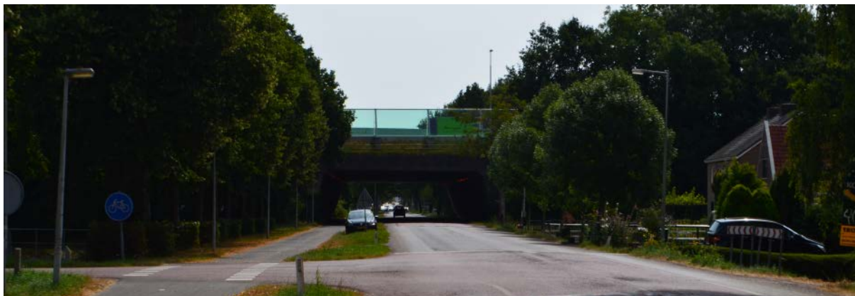
Viaduct A7 over Zuiderweg
