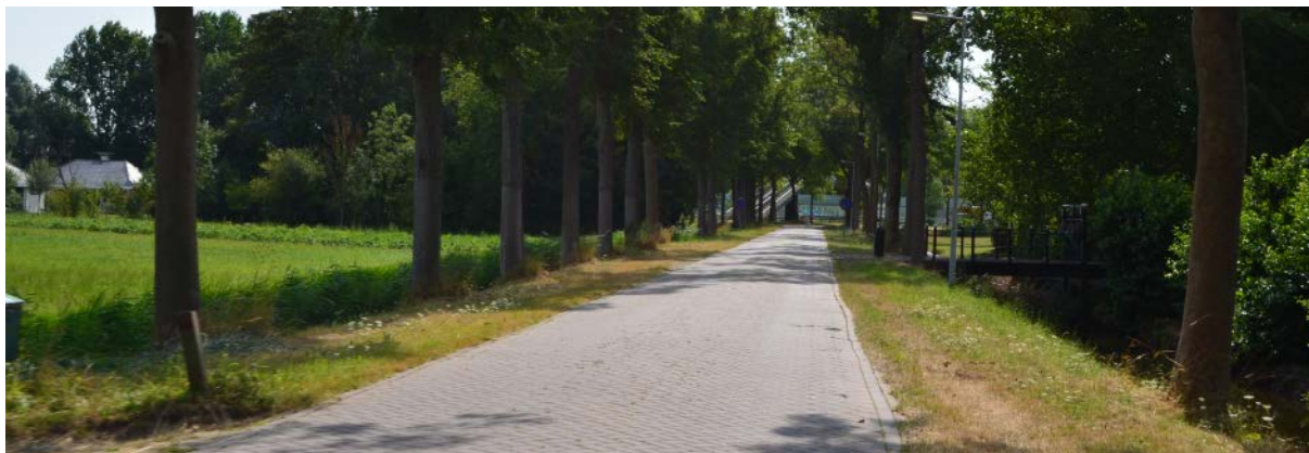
Volgerweg aan westzijde A7, hoofdverdedigingslijn met aan uiteinde het geluidsscherm van de A7
