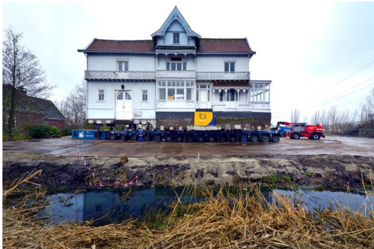
Boerderij de Vechthoeve is op een rijdend ponton geplaatst en wordt naar de Vecht gereden
