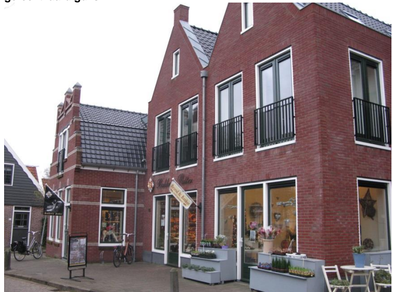
Een voormalige tuinderswoning met bollenschuur (links, Middelweg 4) is gesloopt en herbouwd als onderdeel van een groot complex winkels en appartementen. Wat blijft er dan over van de monumentale status?
