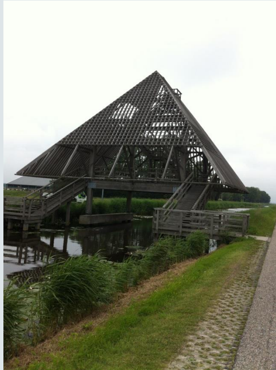
Stoere stolpbrug over de Grote Sloot in Sint Maartensburg ontworpen door Joke Zaal.
