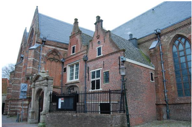
St. Pancras of Zuiderkerk vanaf de noordzijde.
