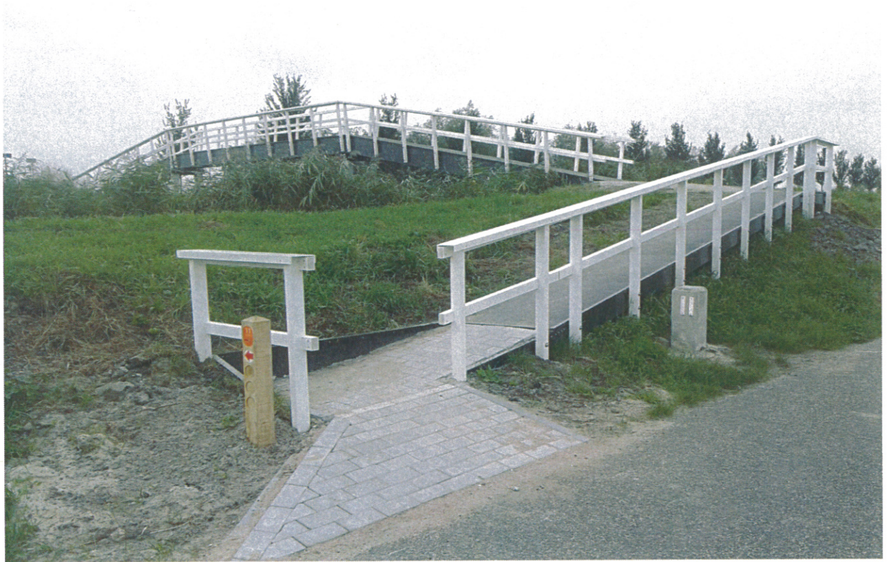
Bijlage voorbeeld brug aan de Noorddijk
