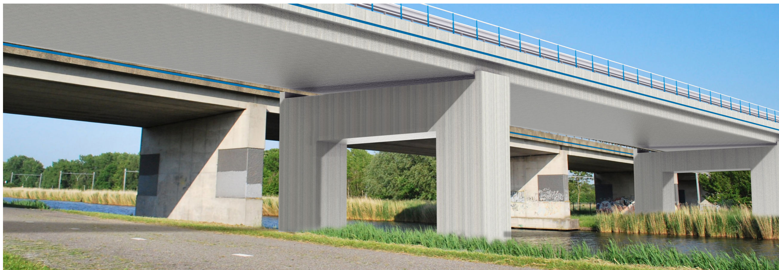
behoud van doorzicht door opengewerkte pijlers
