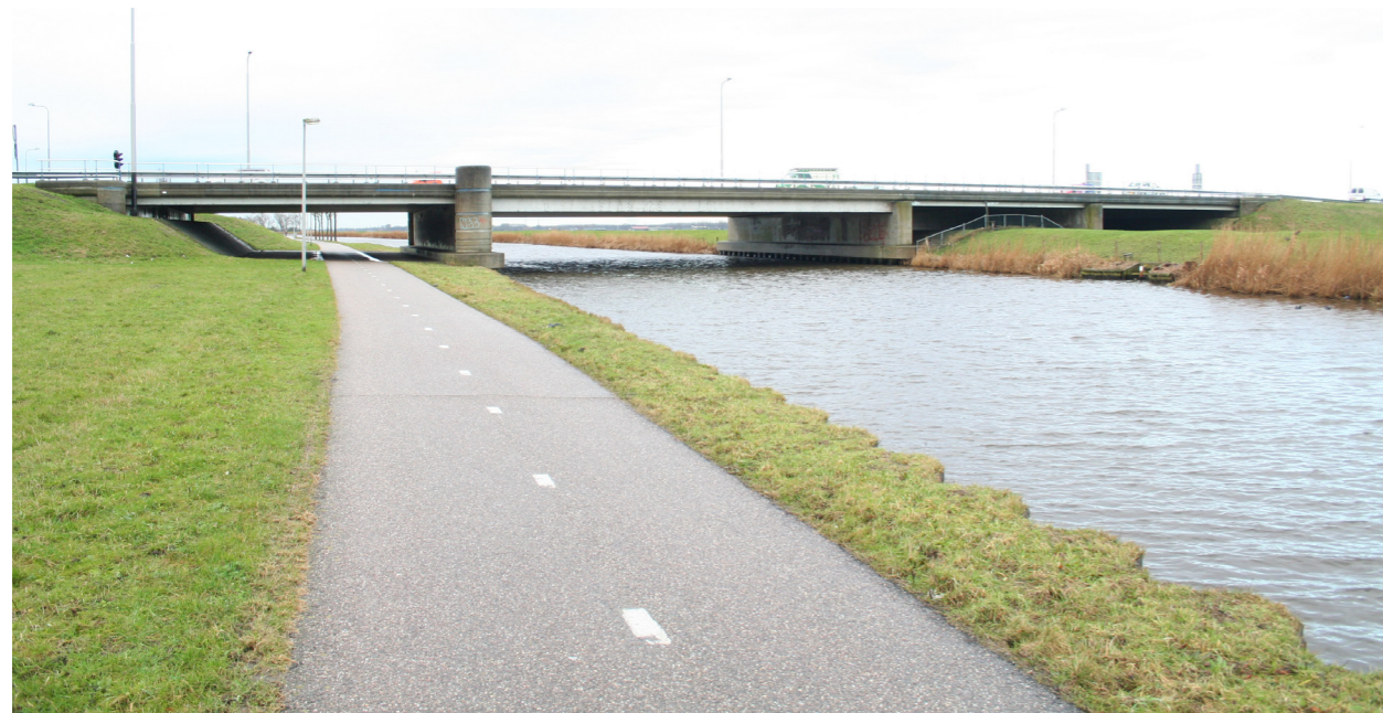
zicht naar N244 en brug
