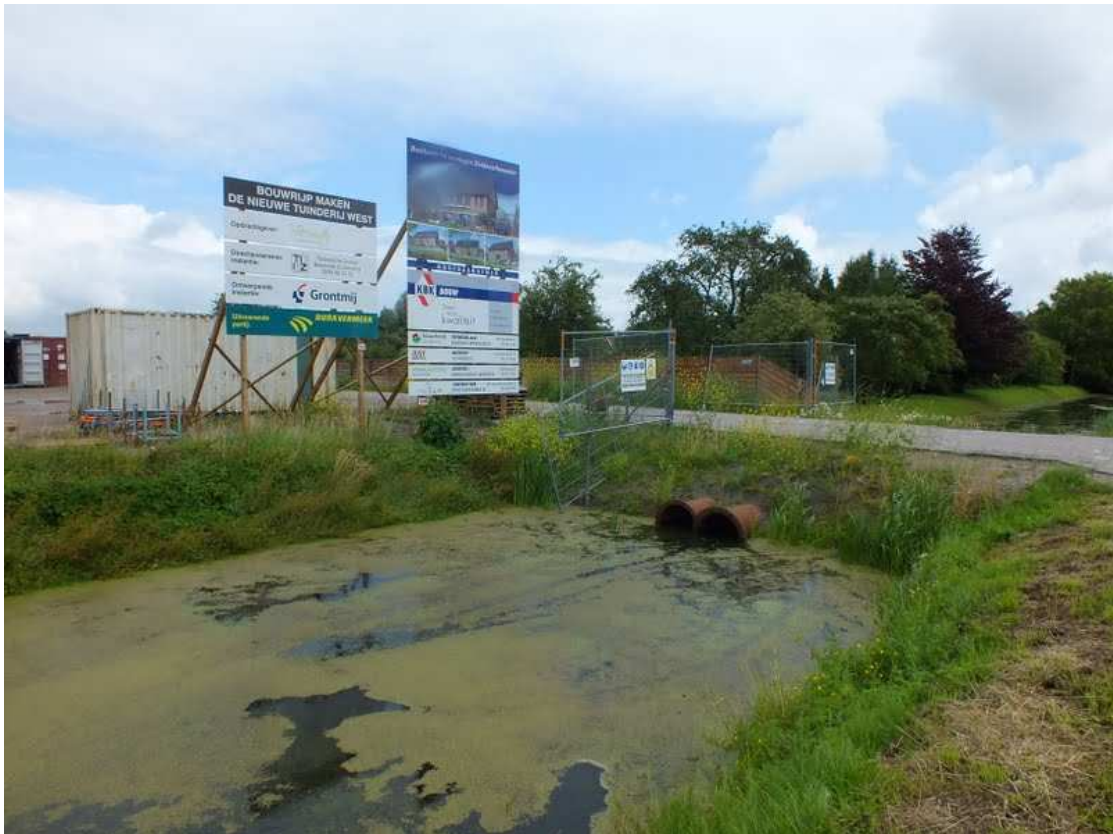
Figuur 15: Bouwrijp maken De Nieuwe Tuinderij West te Zuidoostbeemster (foto: E. Velema)
