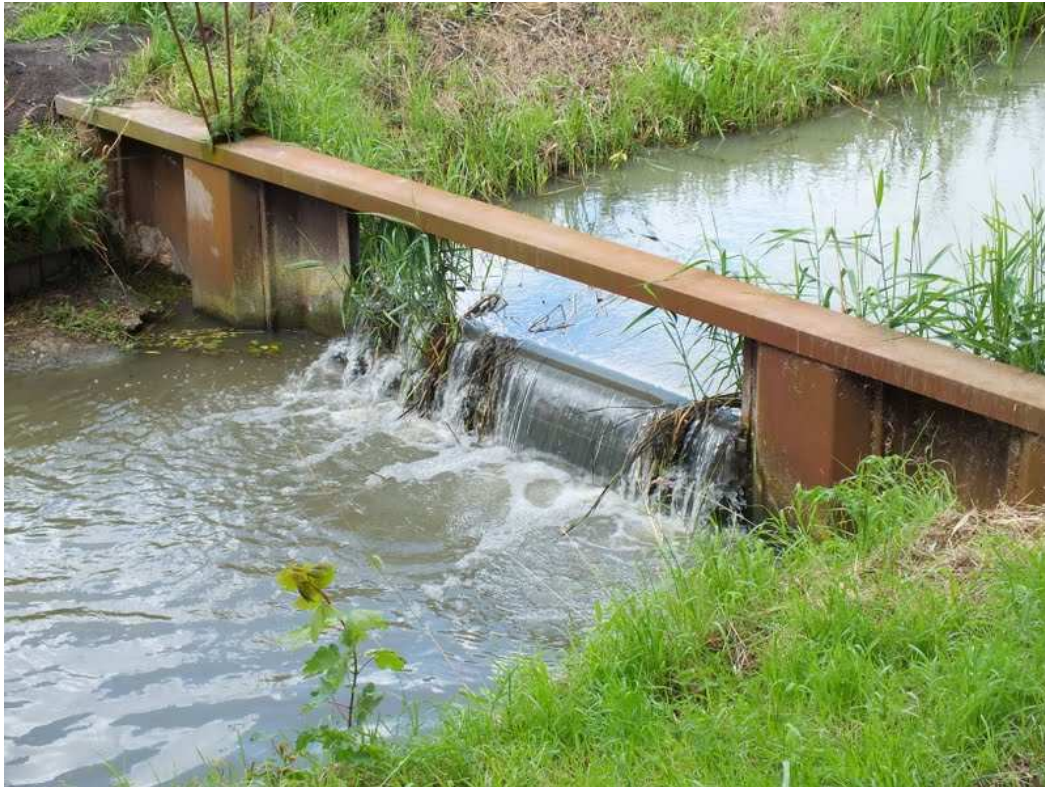
Figuur 9: Vaste stuw in de Beemster
