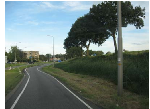
Weg-as verleggen richting dijk
