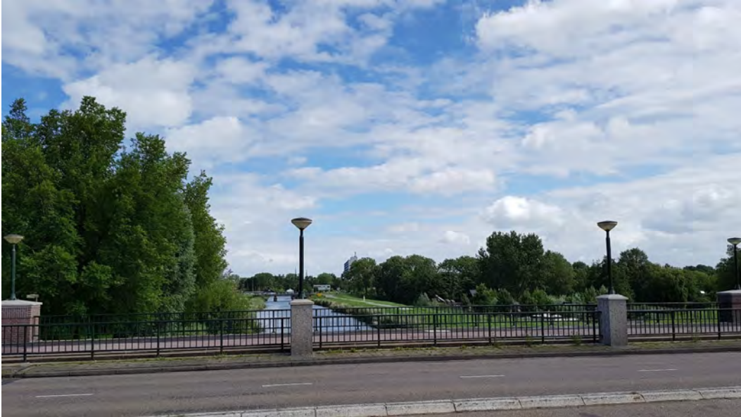
Waterlandbrug over Purmervaart met daarachter het Leeghwaterpark in de lager gelegen polder De Purmer.
