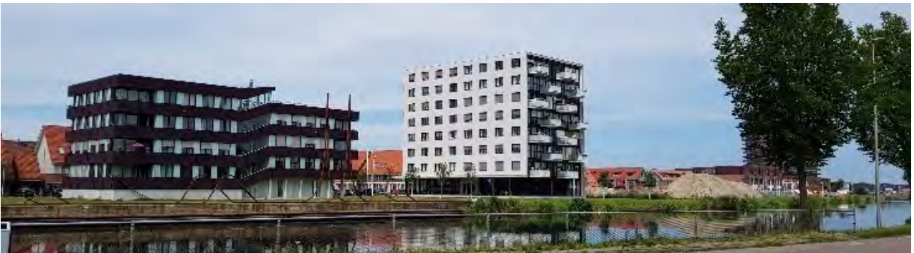
Woningbouw langs kanaal (Weidevenne)
