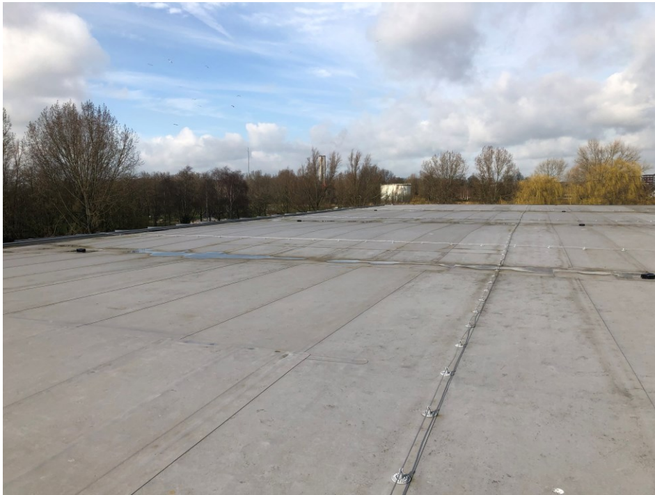
Figuur 12: Een deel van het dak van het Leegwaterbad.
