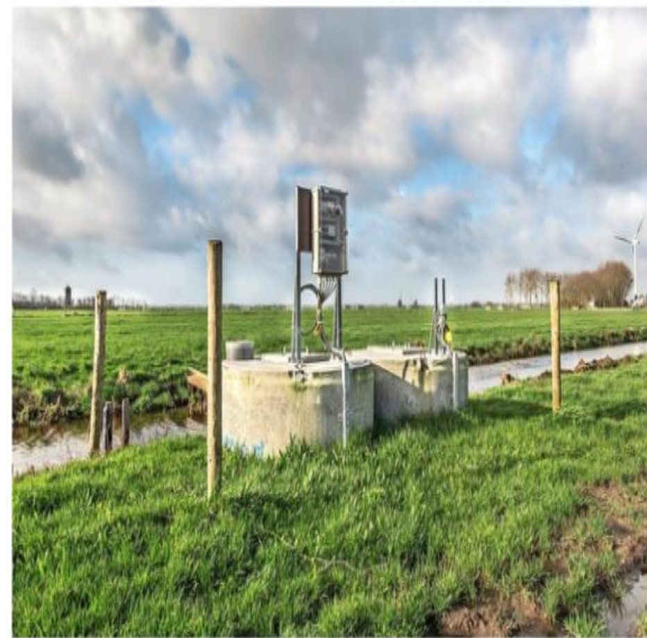
Installatie voor het verhogen of verlagen van het grondwaterpeil met drukdrainage.
